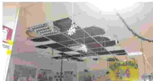
Il tratto di controsoffitto interessato dal crollo
