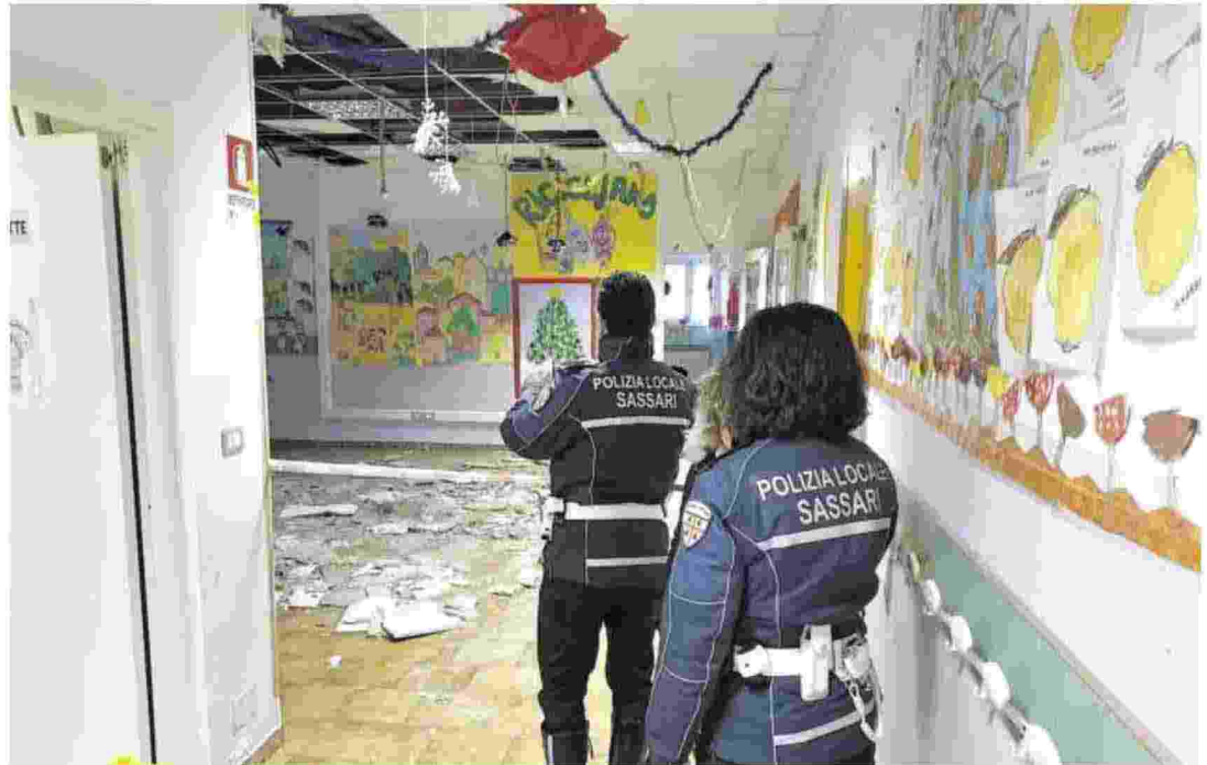
Gli agenti della polizia locale nell'ala della scuola interessata dal crollo e chiusa per ragioni di sicurezza (foto Ivan Nuvoli)
